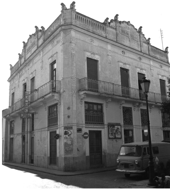
Fig. 119. Antic Sindicat Agrícola d'Albalat dels Sorells l'any 1974, edifici que aquells anys estava situat en la que fou aleshores coneguda com a plaça de José Antonio.
