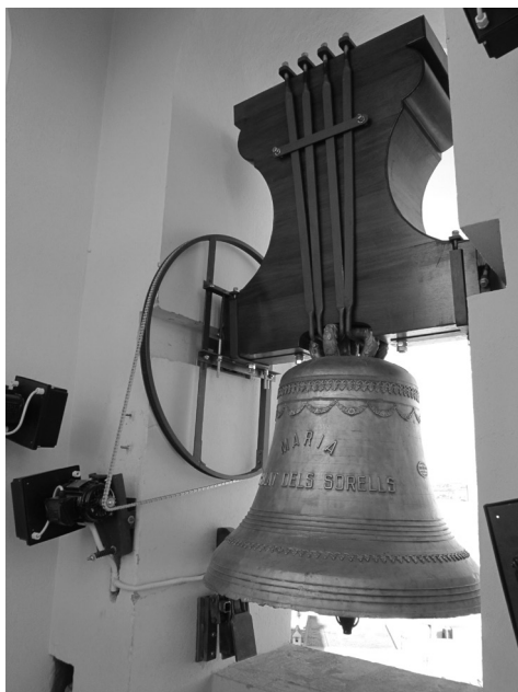
Fig. 63. La campana Maria ja instal·lada en la seua finestra amb tots els seus accessoris i mecanismes de volteig i repic actuals.
