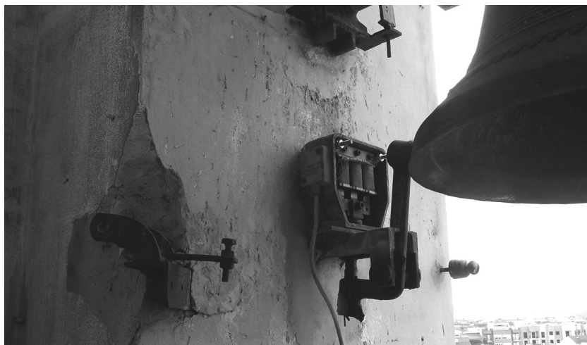
Fig. 57. Caixa exterior metàl·lica de superfície de l'electromall trifàsic que accionava el martell de la campana Els Sants Reis. A l'interior seu podem observar les tres bobines i part de l'aparellatge percutor. En aplicar tensió a les bobines, creaven un camp magnètic que es tancava a través del nucli de xapa magnètica. El flux magnètic originat donava lloc a un parell electromagnètic, superior al parell resistent, a causa dels molls. El parell originat atreïa l'armadura mòbil que estava unida al mànec articulat del martell, i, amb això, s'originava un moviment del cap d'aquest fins a colpejar el bronze. En obrir l'alimentació del circuit de comandament de les bobines, els molls antagonistes deixaven la part mòbil en posició de repòs. Aquest tipus d'electromalls tenien una resposta més lenta que els actuals, així com més agressius amb el bronze. Al mig de la imatge i a la part inferior, es pot veure un dels dos aïlladors de porcellana que encara hi ha i que es remunten als anys prebèl·lics.
