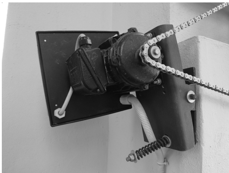
Fig. 65. Sistema de tracció electromecànic de la campana Sants Abdó i Senén. El pinyó queda fixat en l'eix amb l'ajuda de la xaveta (Fig. 42), per evitar el patinatge sobre el seu caragol d'M6 i roscat amb volandera. En la caixa negra muntada en la tapa deflector posterior del motor és on estan els components electrònics (Ecatron) per al governament i control de la màquina elèctrica rotativa.
