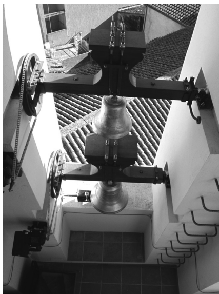
Fig. 21. Perspectiva aèria de la finestra on estan col·locades les campanes Sant Eduard Rei i Sants Abdó i Senén actualment. En el braç dret del cimbalet es pot veure la ballesta per a facilitar la tracció manual amb corda d'aquesta campana.
