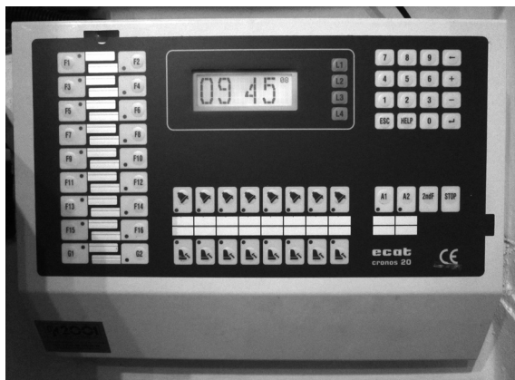
Fig. 144. Panell sinòptic de l'ordinador de campanes model Ecat Cronos 20 instal·lat a la sagristia. Aquest quadre no es va canviar en l'any 2013, sinó que es va mantenir el mateix que fou muntat per l'empresa Industrias Manclús envers l'any 2005. Els tècnics de l'empresa 2001 Tècnica y Artesanía SL el van readaptar a les noves seqüències de volteig, mig vol i repic de les campanes.
