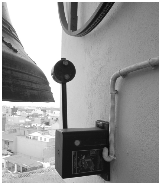
Fig. 76. Electromall de repic d'última generació de la marca Ecat Orologi-campane, instal·lat en la finestra de la campana Santíssim Crist de les Ànimes. Els actuals sistemes de repic monofàsics són més ràpids en la resposta, i poden arribar a donar 3 o 4 colps, segons la mida de la campana i la distància a què està la bola del martell del bronze.
