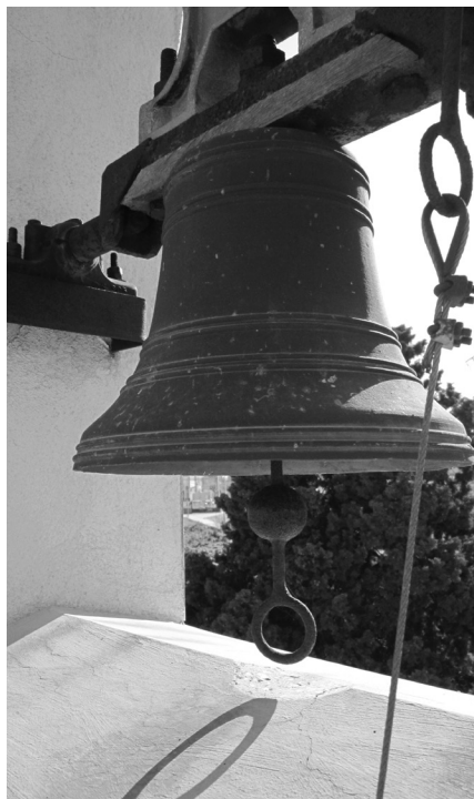
Fig. 36. Detall del bronze i del batall de la campana de l'ermita del Cementeri. Ací podem observar clarament el llistó de fusta que separa el bronze de l'eix metàl·lic, amb la qual cosa la vibració del bronze s'allarga durant el temps de propagació del so.
