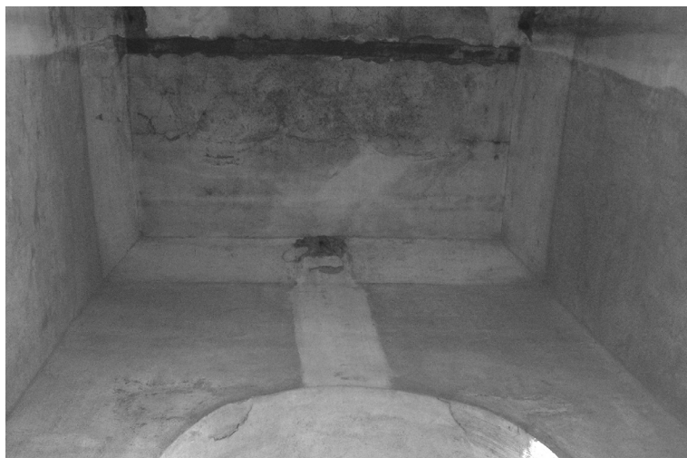
Fig. 18. Detall de la «falsa volta» del campanar reconstruïda entre els anys de 1941 i 1942.
