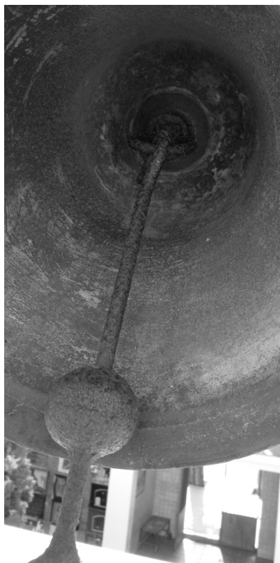
Fig. 113. Vista interior de la campana de l'ermita del cementeri. En la instantània es pot apreciar el detall de la subjecció del batall amb l'anella batallera, la canya i la bola del batall, tots en un procés d'oxidació avançat.
