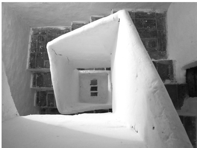
Fig. 132. Vista en planta dels tres forats per on passaven les cordes per fer els repics de les campanes fins l'any 1985. La fotografia està feta des de l'escala «a la castellana» d'accés al cor i la torre campanar. Tal com vam tenir ocasió de comentar, l'escala té 79 graons des de la base fins a la sala de campanes. Cada graó té 22 cm d'altura i tots salven un desnivell de 17,26 m. Era des del replanell de l'entrada des d'on s'estiraven les tres cordes que anaven lligades als mugrons dels batalls de les campanes majors. Pel forat superior de la imatge passava la corda de la campana Maria, pel del mig la de la campana Santíssim Crist de les Ànimes, i per l'inferior ho feia la que estava unida al mugró del batall de la campana Els Sants Reis.
